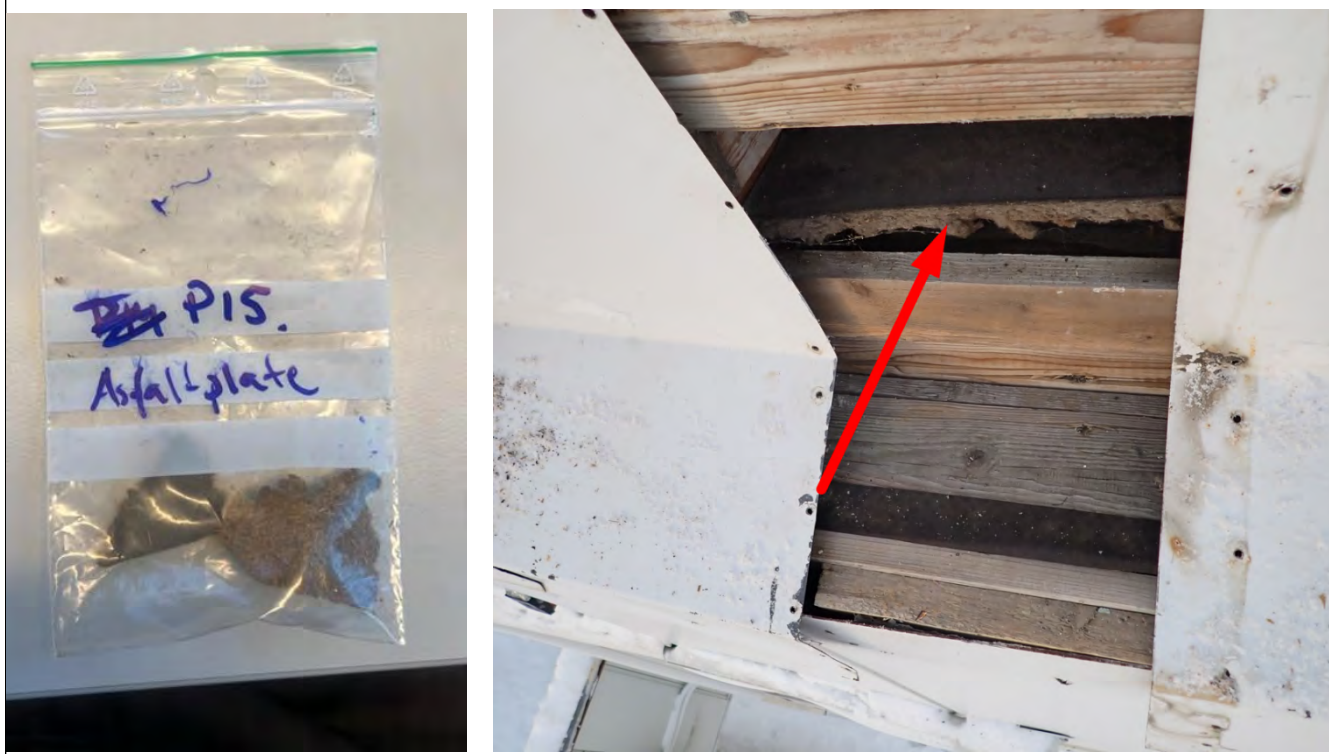
Bilde B15: P15, Asfaltplate over taktro, tak 80-tallsbygg( del 2)
