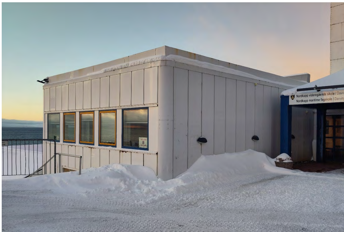
Figur 5: Fasade fra 80-tallet ved hovedinngangen. Vertikale metallplater med rundete hjørner.
