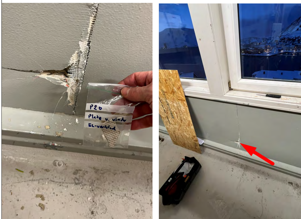
Bilde B20: P20 Plate under vindu, el-verksted. Fasade sør, verkstedsfløy. 80-tallsbygg(del 4)
