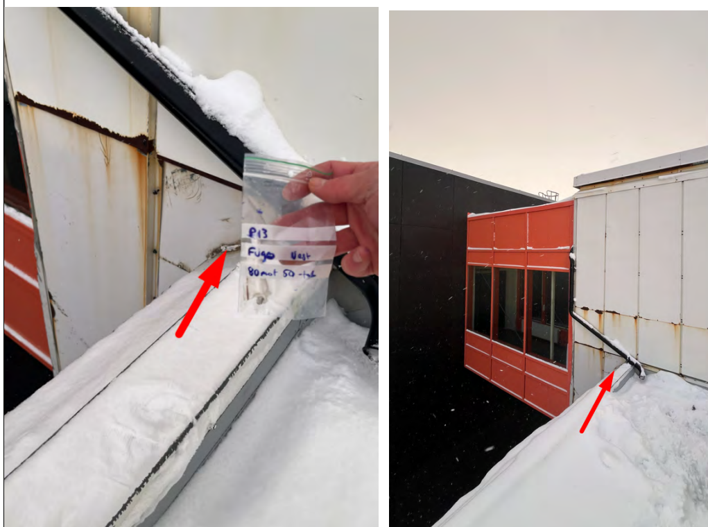
Bilde B13: P13 Fuge i overgang mellom byggetrinn, Fasade Vest/nord (1950 del 2 vs. 1980 del 1)
