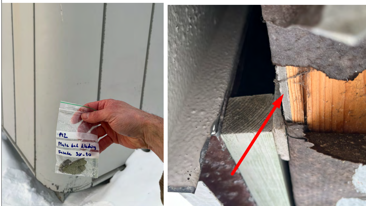
Bilde B12: P12 Plate bak kledning, Fasade hjørne Sør -øst (del 4), 80-talsbygg
