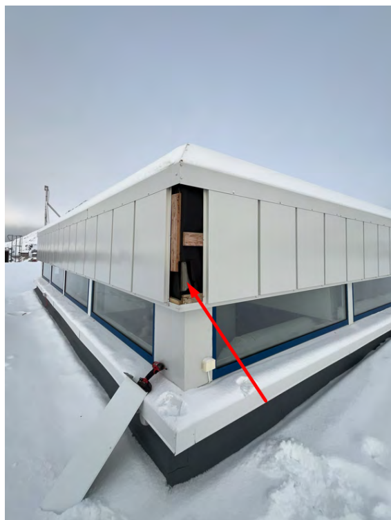
Bilde B17: P17, Plate bak kledning, Fasade vest, 80 tallsbygg (del 5, over bibliotek)
