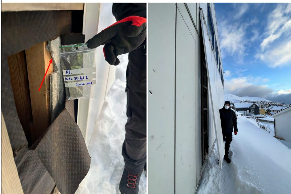
Bilde B2: P2, Vindsperre, Fasade Sør (del 2), 80-tallsbygg.
